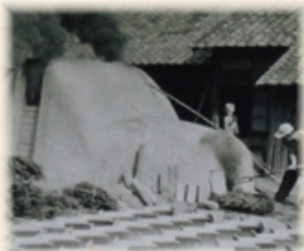
達磨窯を使った瓦作り
