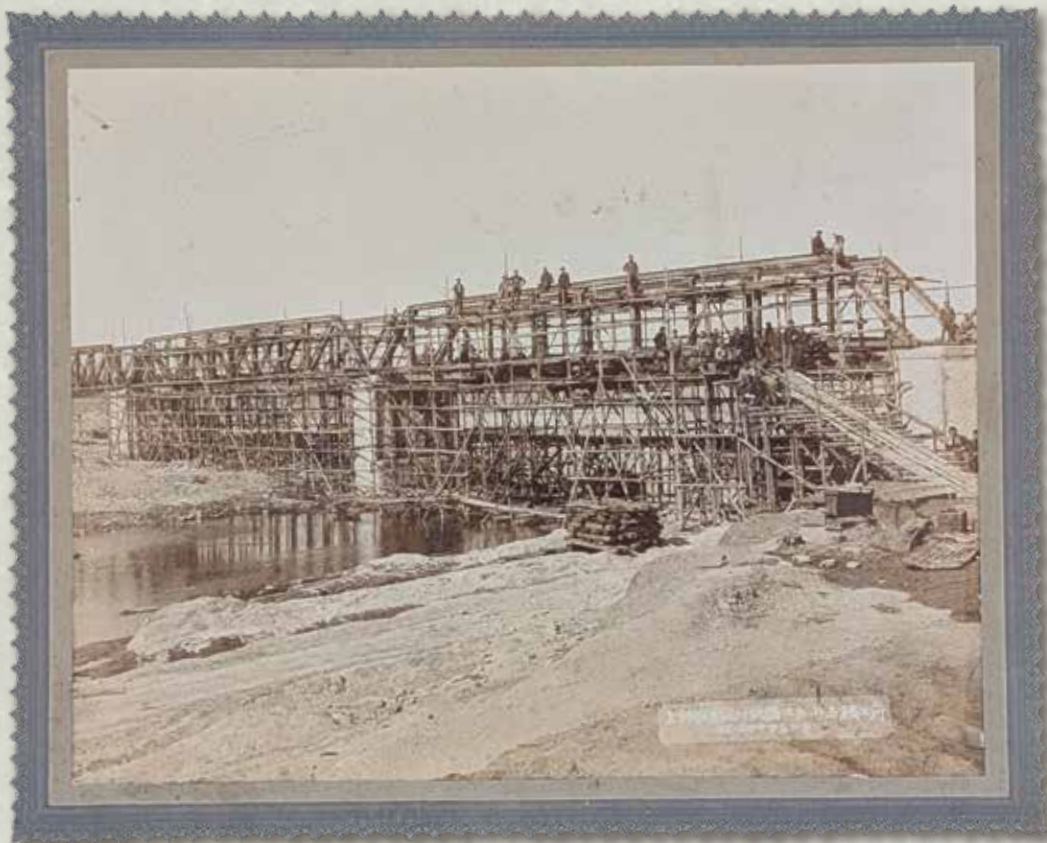
上野鉄道(現上信電鉄)による鐺川鉄橋工事風景 (明治44年)
