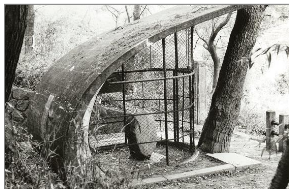
1985 年（昭和 60）頃の金井沢碑覆屋写真 （高崎市教育委員会蔵）斬新なデザインが目を 引く覆屋。この後、現在の覆屋に改築された。
